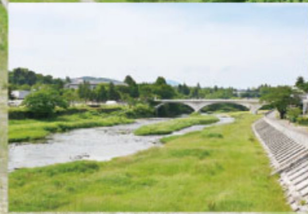
青葉山から大手町の間に架かる大橋
