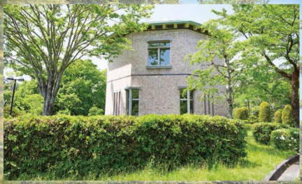
仙台市水道記念館。水道の仕組みや、水と森林の関わりなどについて学べる施設
