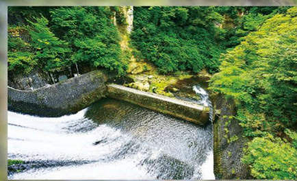
青下川は、青下第一ダムを越水した先で広瀬川と合流する
